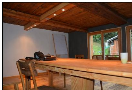
Figur 35. Hvit og svart vegg bygget opp av biokull, plastret vegg. Tykkelse på den hvite vegg er 7 cm med rør for rom-oppvarming. (Foto: Schmidt)
